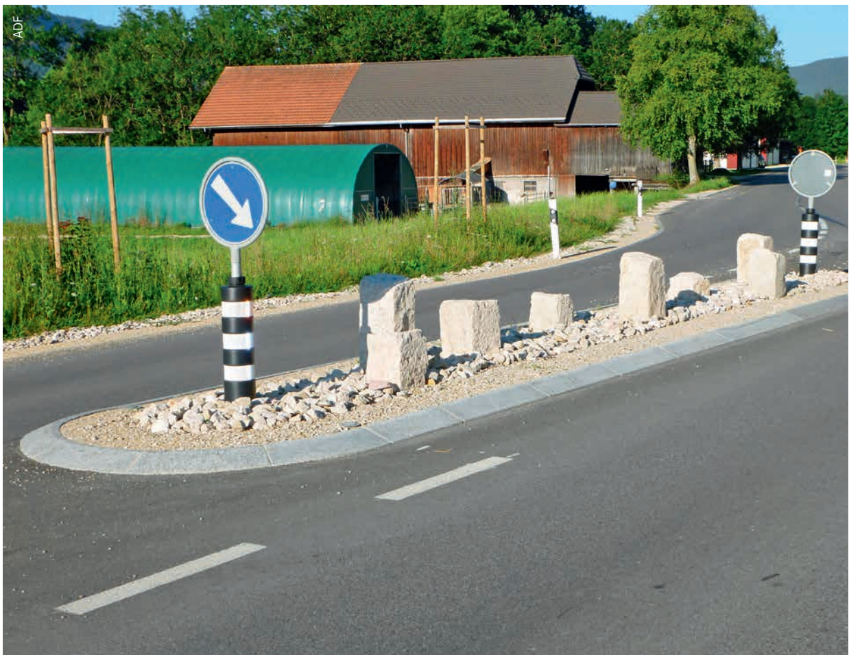
Verkehrssinsel als Aussentor bei einer Ortseinfahrt: Die angeschrägte Umrandung verhindert Beschädigungen der Reifen beim Touchieren der Randsteine.
